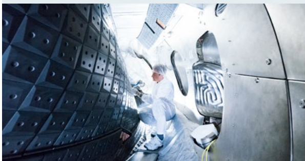
Montage der Graphitkacheln im Plasmagefäß von Wendelstein 7-X
