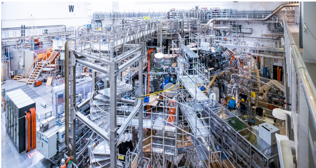
Blick in die Experimentierhalle und auf die Fusionsanlage Wendelstein 7-X
