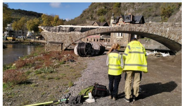
Von der Flutkatastrophe zerstörte Eisenbahnbrücke bei Ahrweiler
