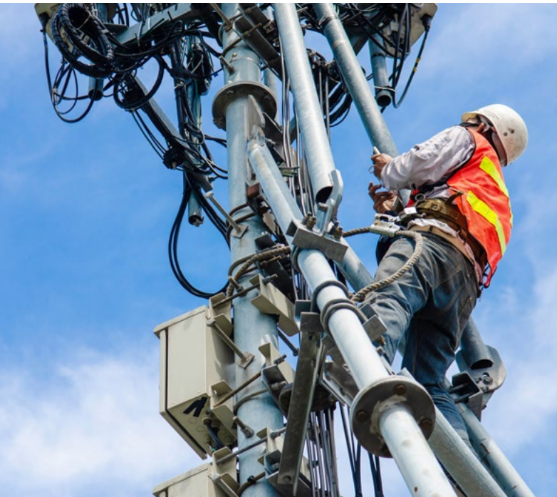
Arbeiten an einem Funkmast
